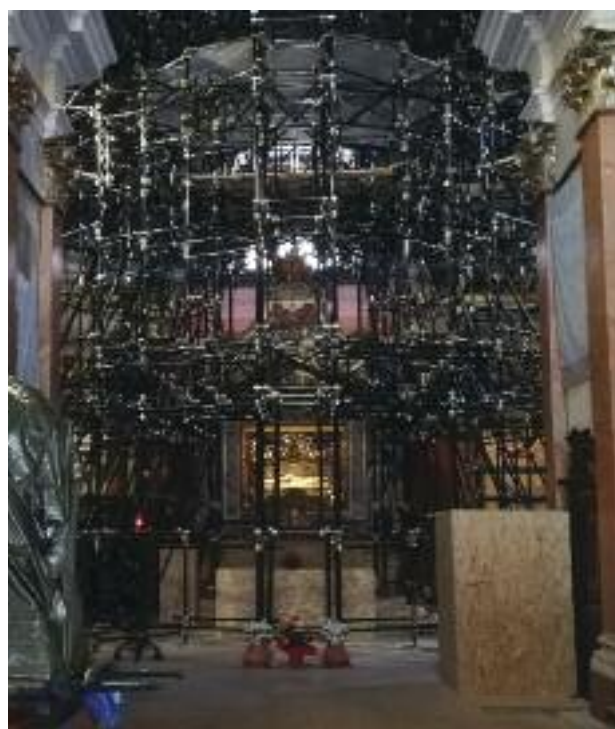
Santuario di S. Giuseppe: impalcatura interna per la messa in sicurezza
