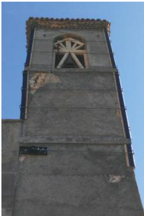
Messa in sicurezza del campanile di Viesci
