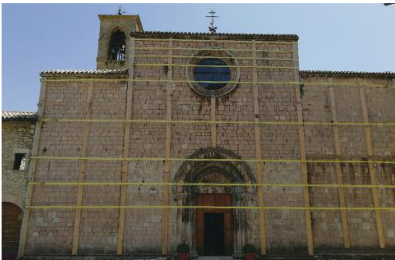
Chiesa di S. Francesco: opera provvisoria di tirantatura tramite fasce in poliestere e profilati in acciaio
